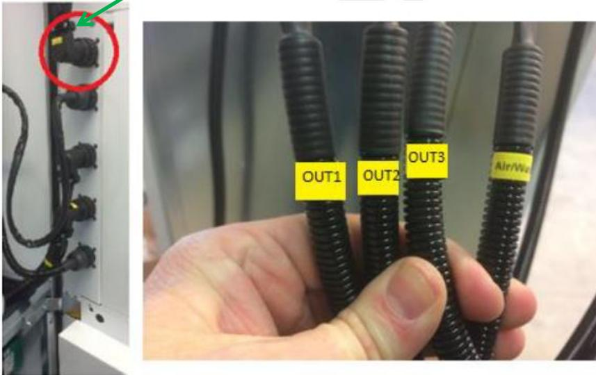
I/O kabel består af 3 kabler mærket OUT1, OUT2, OUT3 samt Air/Water. OUT1, OUT2 eller OUT3 kobles til ESBE ventilerne, eller til at styre eksternt elkolbe, f.eks. til spidslast i varmesystemet eller til eksternt AL-styring
